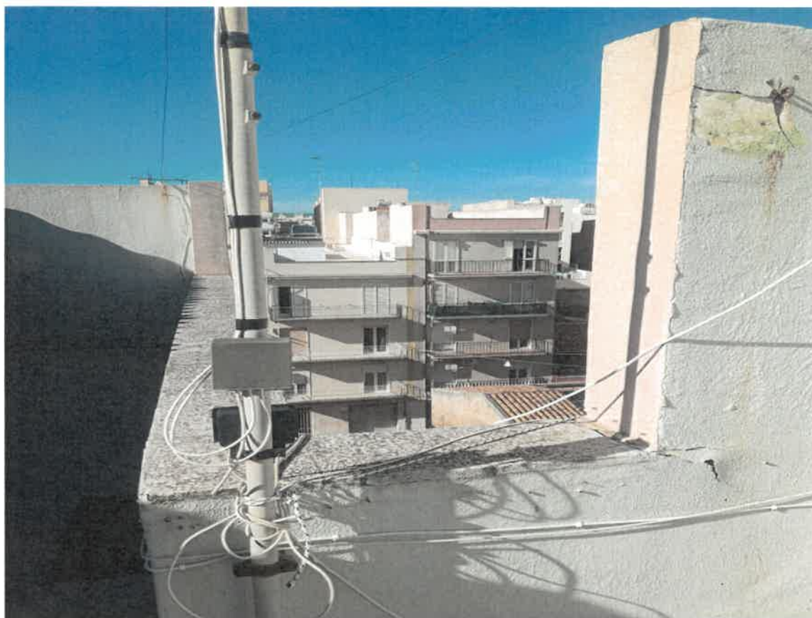
Foto n.ro 48 : altri dettagli del terrazzo condominiale
