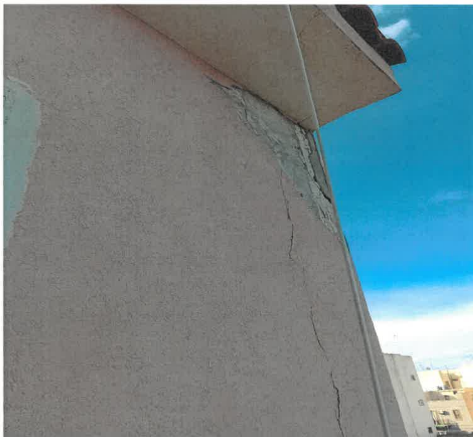
Foto n.ro 41 pilastro d'angolo del soggiorno
