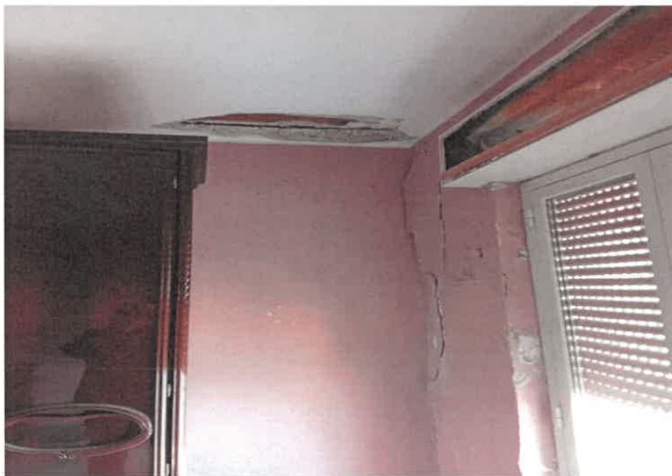
Foto n.ro 15 . dettagli salone , confine nord
