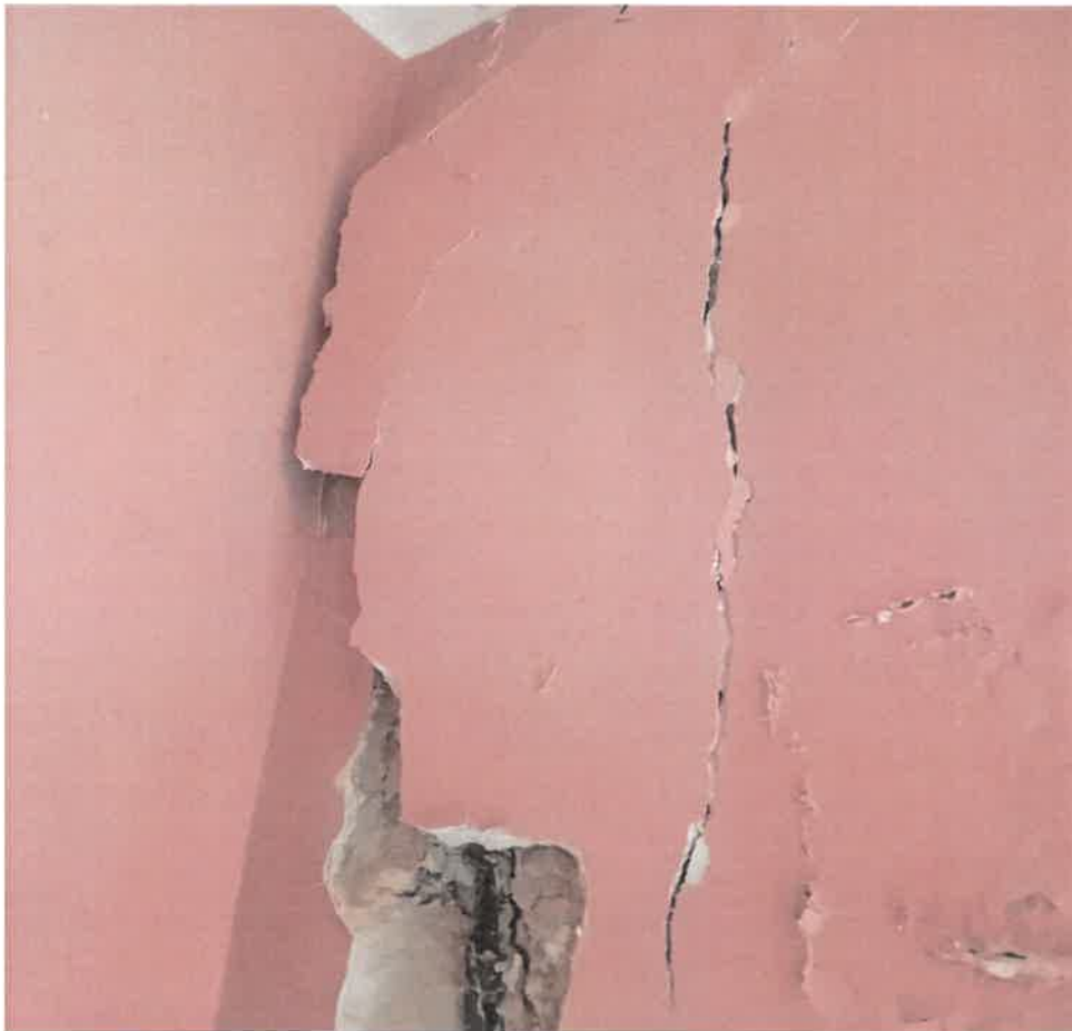
Foto n.ro 14- dettaglio copriferro pilastro ammalorato con armature in vista
