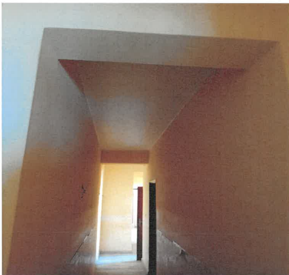
Foto n.ro 38 : dettagli travi in c.a. corridoio
