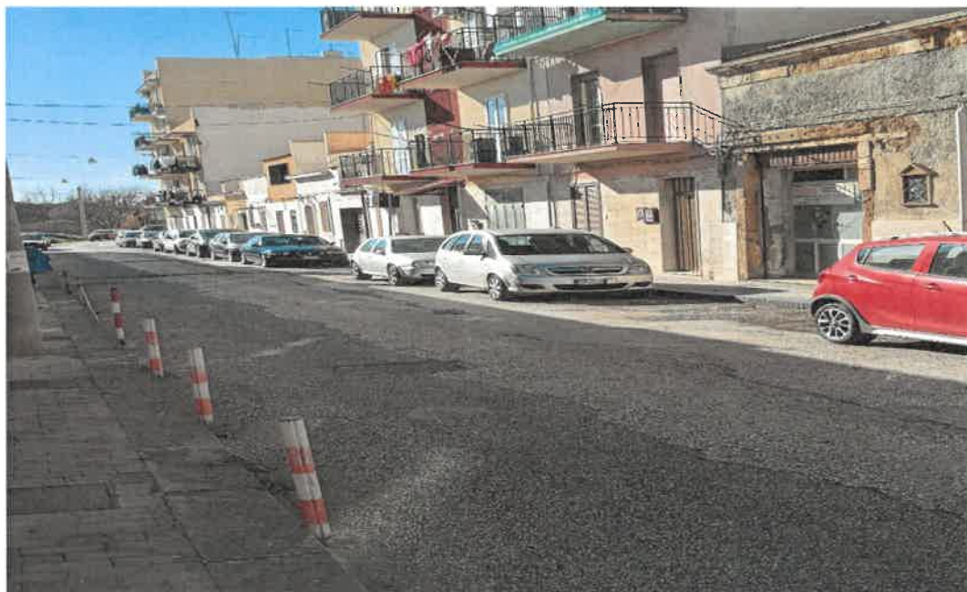
Foto n.ro 2 -via dei cordai AUGUSTA
