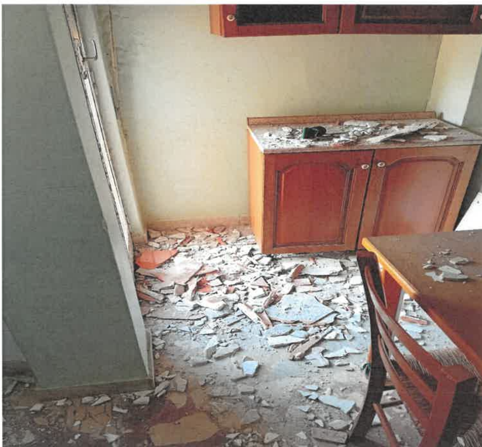
Foto n.ri 24-25 : altri dettagli locali cucina e particolari distacchi di intonaco dal soffitto
