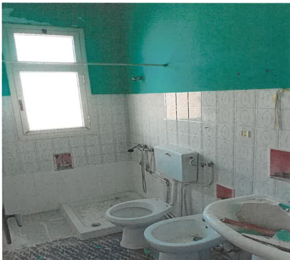
Foto n.ro 30 : il locale bagno
